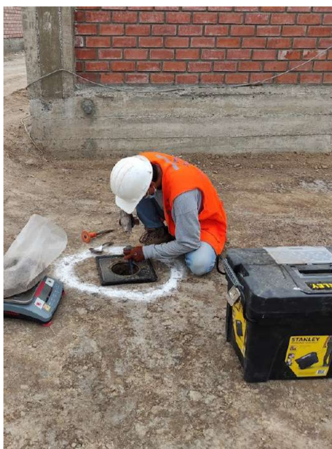
PROYECTO: CONTROL DE CALIDAD OBRA VIAMONT, LIMA / LIMA / LIMA.
