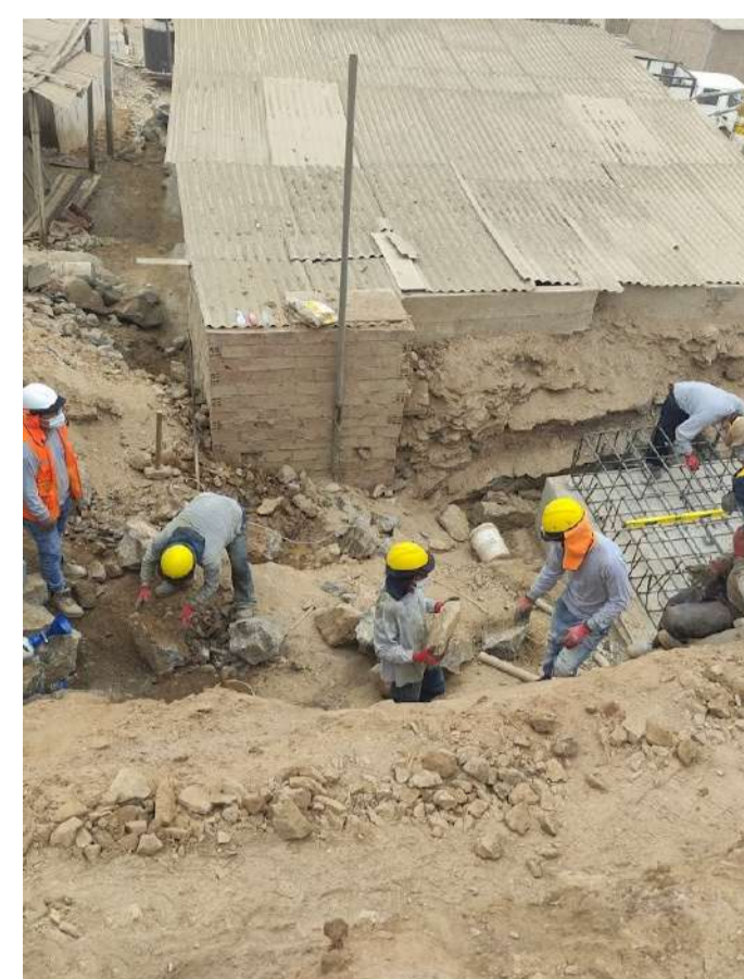
PROYECTO: CONTROL DE CALIDAD DE MUROS DE CONTENCIÓN, CARABAYLLO / LIMA / LIMA
