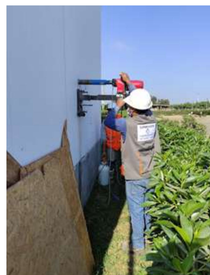
PROYECTO: EVALUACION ESTRUCTURAL "VIVIENDA DE PLAYA LUNA ARENA - PANAMERICANA SUR KM 197.5 CONDIMINIO LUNARENA, CHINCHA / ICA
