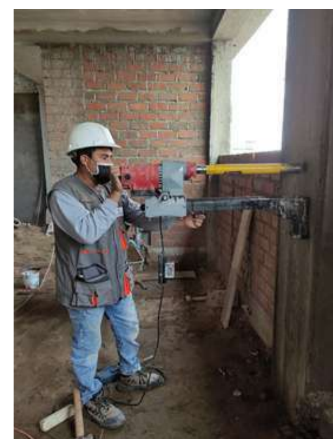
PROYECTO: EVALUACIÓN ESTRUCTURAL DE VIVIENDA MULTIFAMILIAR, ATE / LIMA / LIMA
